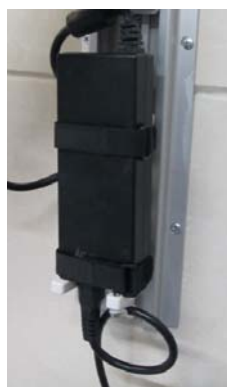
安装完毕的电源支架
