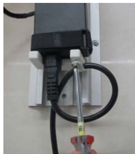
使用固定器固定电线
