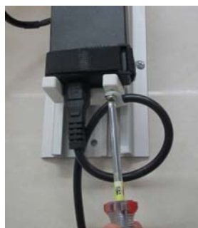
使用固定器固定电线
