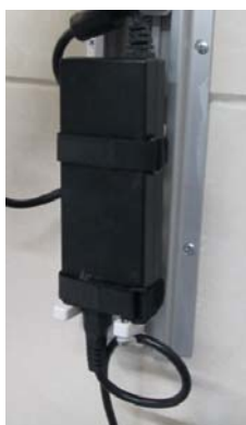
安装完毕的电源支架
