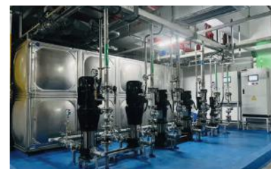
■ 锅炉冷凝水回收项目
